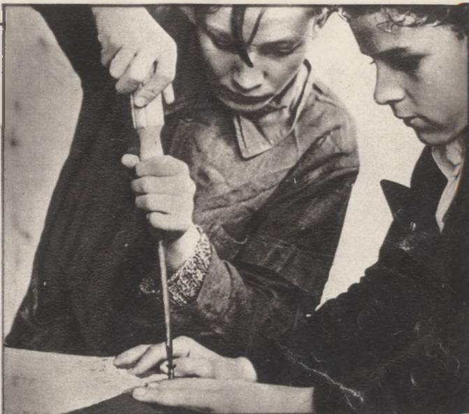
La suspension correcte de différents objets sur les murs, refends ou cloisons, relève d'une technique qui comprend généralement trois opérations : perçage, chevillage, vissage. Il est nécessaire de les exécuter à l'aide d'outils bien appropriés, pour éviter les éclatements désastreux, les malfaçons et déboires de tous ordres.
